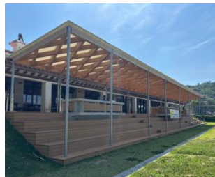
▲ 高低差を活かした休憩スペース
