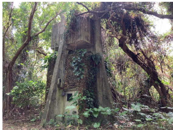
老朽化し、使用されていない給水塔
