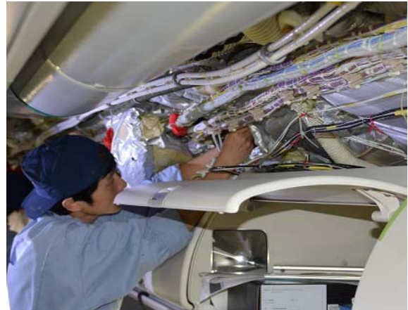
【点検・修復作業】
