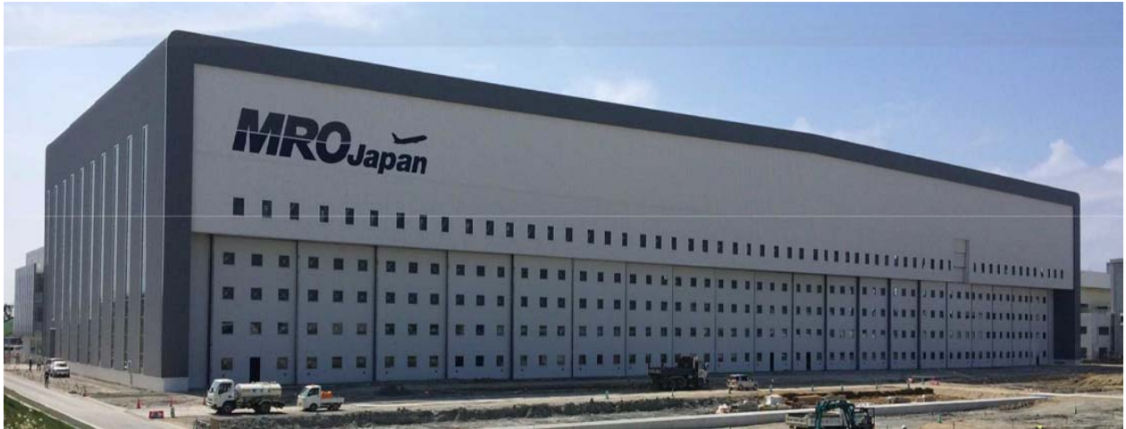
【那覇空港内の格納庫施設】
