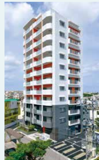
▼ 建替え後（竣工時）
