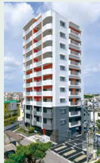
▼ 建替え後（竣工時）
