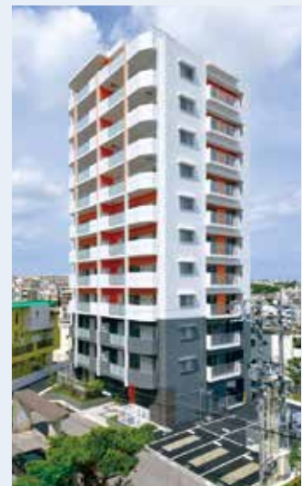
▼ 建替え後（竣工時）
