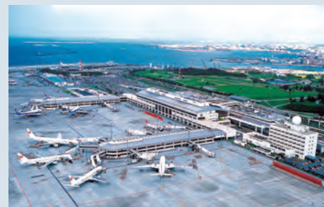
国内線新旅客ターミナルビル(1999年)
